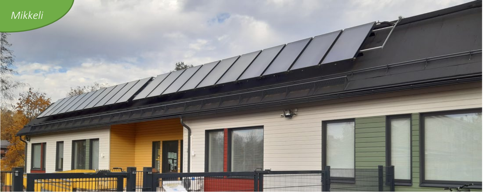
Naisvuoren päiväkodilla lämmitetään vesi aurinkokeräimillä.
