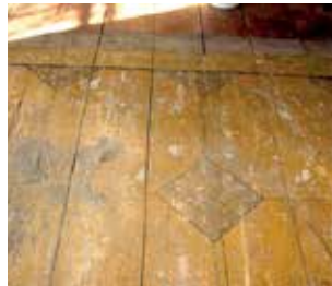
Päiväkotikäytön ajaksi sisäseinien ja lattiaan asetettujen lastulevyjen alla olivat säilyneet alkuperäiset koristekuvioiset puulattiat ja seinämaalaukset, jotka saatiin ennallistavan peruskorjauksen myötä kunnostettua. Kuvat: Jorma Oikari
